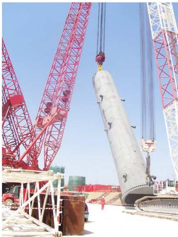
**Figura 1** – Reator de hidrotreatamento de petróleo [4].
