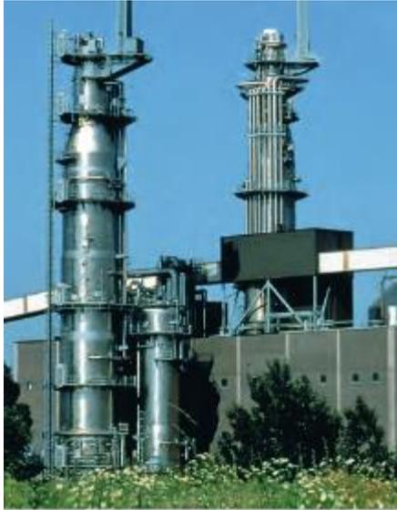
Figura II.1.1.1: Torre de impregnação e digestão contínua de polpa de sulfato em aço Dúplex 2205, Sodra Cell Mönsterås, Suécia. © Kvaerner Pulping[7].
