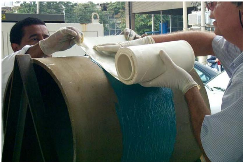
Figura 3.5 – Material MC3 da empresa StrongBack Corporation sendo aplicado sobre um segmento de duto [59].
