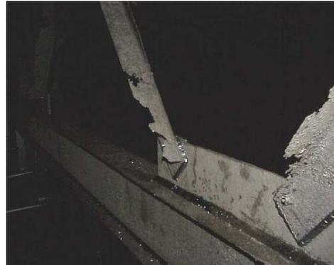
FIGURA 14 – Aspecto da corrosão em internos de Torres de Processo
