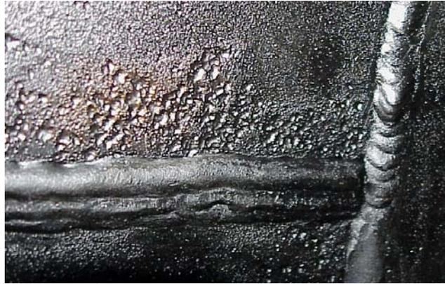
FIGURA 13 – Aspecto da corrosão por condensação é costado de Torre
