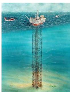
**Figura 3 - Plataforma de Torre Complacente (*Compliant Towers*).**
