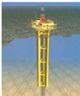
**Figura 6 - Plataforma Spar Buoy.**
