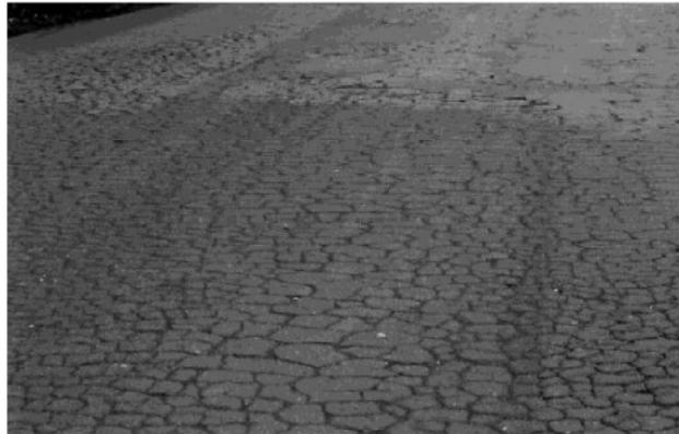
Figura 39- Semelhança entre um filme de asfaltenos(principal componente para fragilidade e formação de trincas) e as trincas do asfalto na pavimentação
