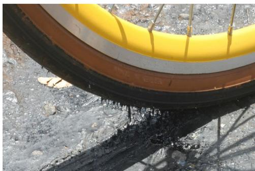
Figura 52 – Derretimento do asfalto de rodovias causado por excesso de ligante
