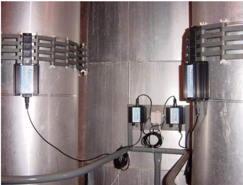
Figura 9: Equipamento experimental para controle de incrustações por campo magnético (adaptado de [43])
