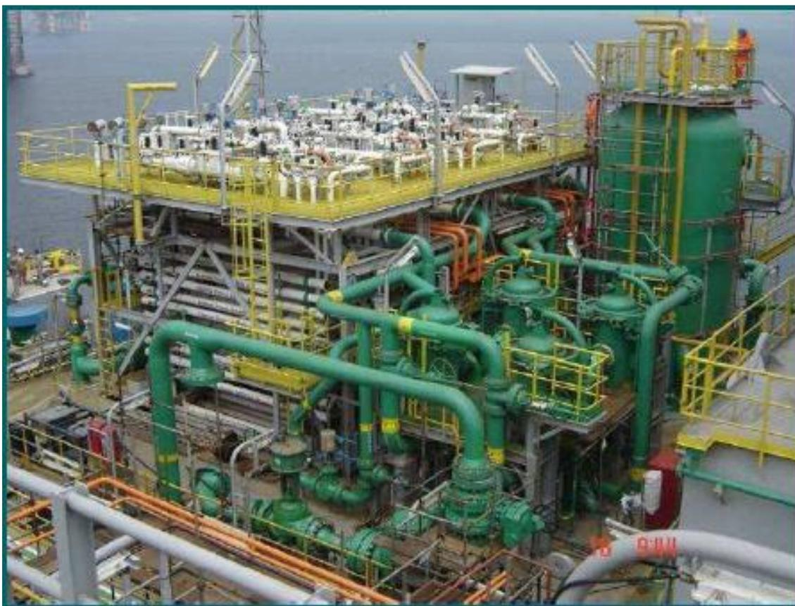
Figura 8: Unidade de Remoção de Sulfato (adaptado de [42])
