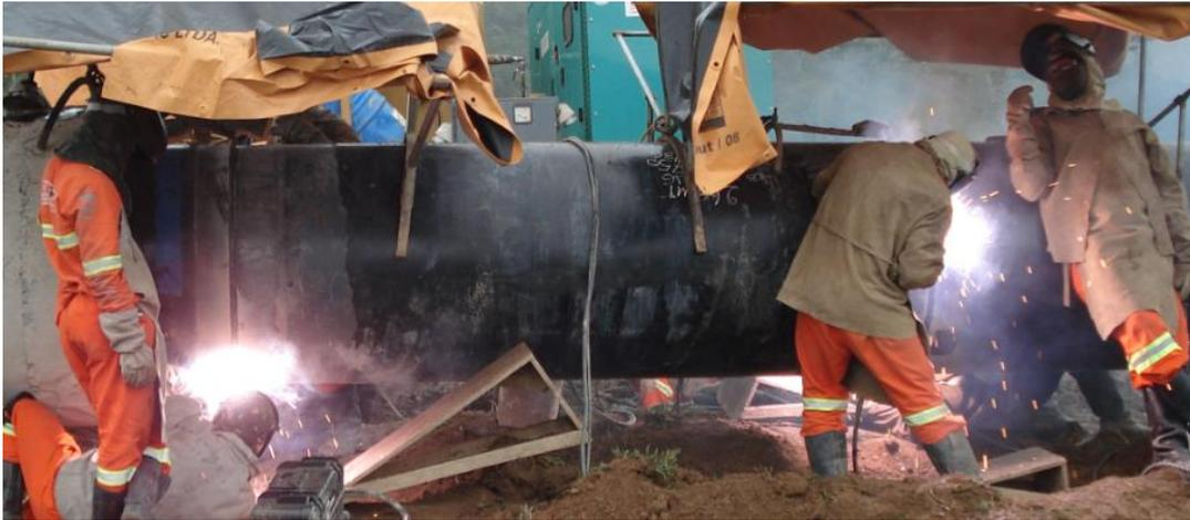
Figura 11: Soldagem de duto no campo. Na imagem observa-se o tubo parado na horizontal e duas juntas sendo soldadas. No momento da fotografia o soldador da esquerda está soldando na posição sobre cabeça, enquanto o soldador da direita está na posição vertical.
