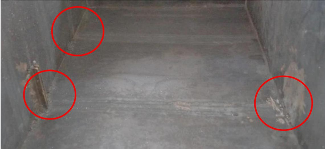
Figura 26 Zonas que apresentaram corrosão devido a soldagem demarcadas em vermelho.
